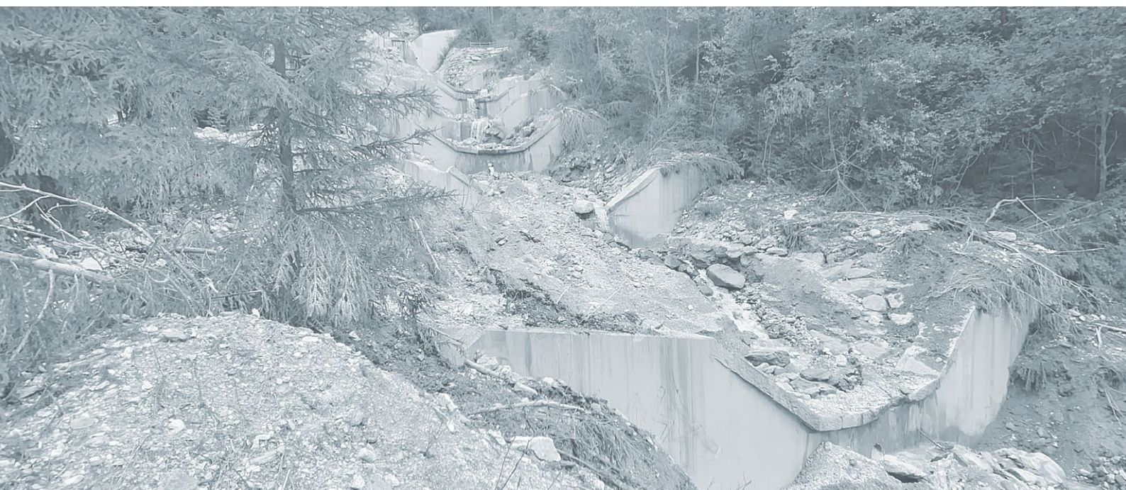
Beschädigte Sperrenstaffelung nach dem Murreignis im Juli 2022 am Margaretenbach in Fulpmes (Quelle: WLW).
