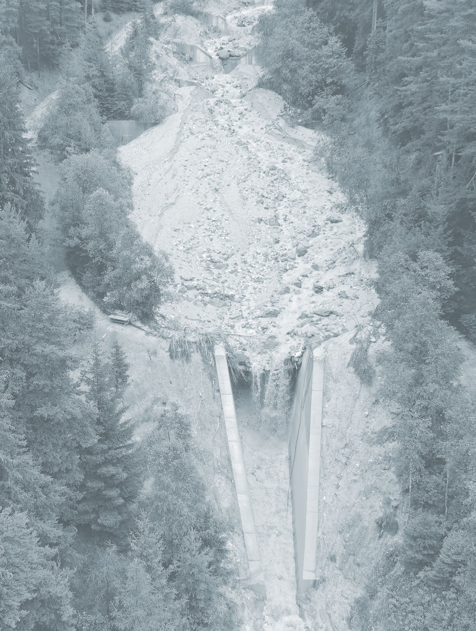
Volle Geschießerückhaltesperre nach dem Ereignis im Juli 2022 am Margaretenbach in Fulpmes (Quelle: BFV Kufstein).
