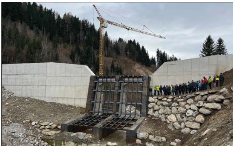
Slika 1: Gradnja velike hudourniške lovilne prebiralne pregrade na hudourniku Kaningerbach v Avstriji (foto: M. Kobal)
