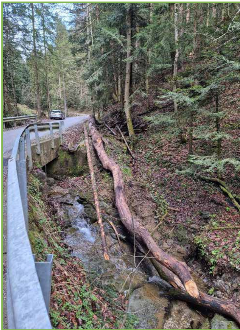
Figura 29: Una gestione forestale errata e i residui nei corsi d'acqua sono vere e proprie trappole? per la strada
